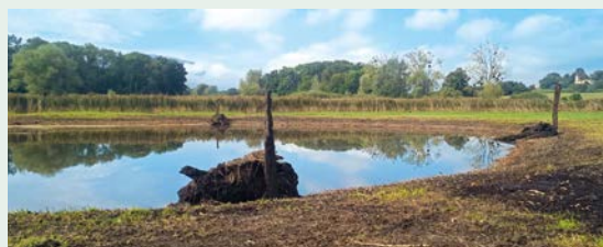
Ci-dessus de haut en bas: 1. Faucardage au 26 août 2024 - 2. Curage en cours au 28 août 2024 - 3. Fin du chantier au 2 septembre 2024
